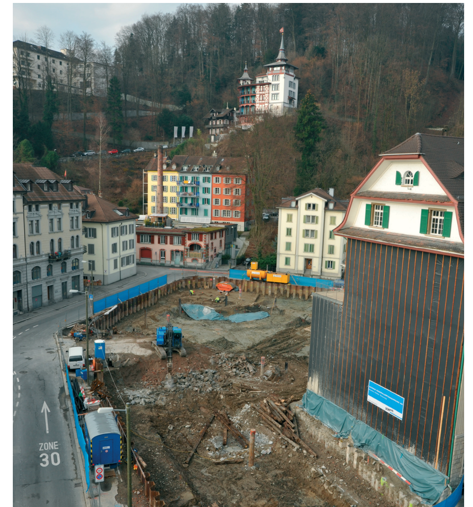
Übersicht über die Baustelle an der Gibraltarstrasse in Luzern
