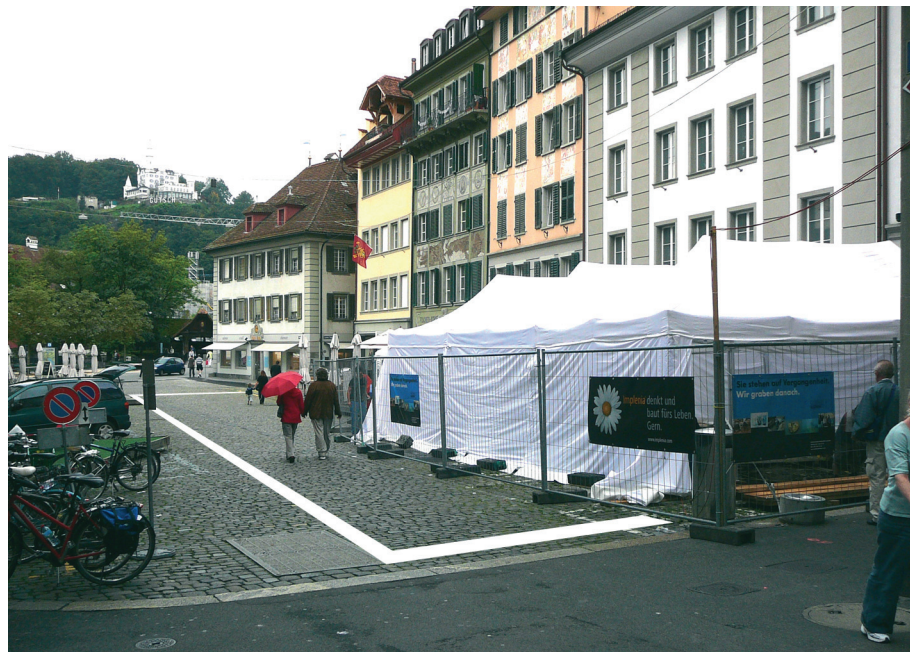
Der Mühlenplatz mit den Grabungszelten. Die Ausdehnung der verschwundenen Häuser ist mit einer weissen Linie am Boden markiert. Bei den Bäumen im Hintergrund liegt bereits die Reuss.
